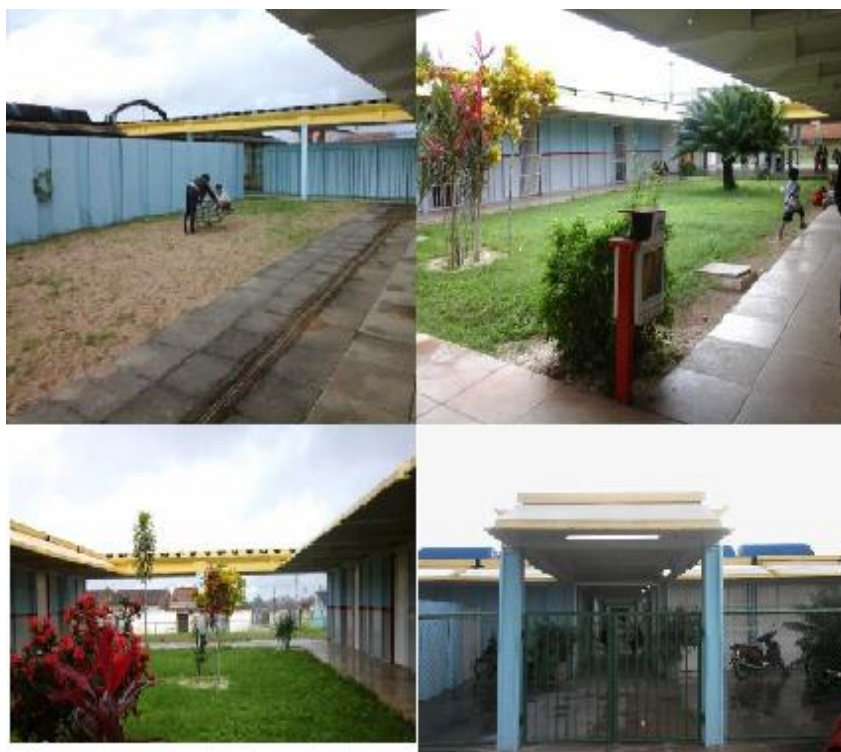
Figura 1: Infra estrutura do prédio.
