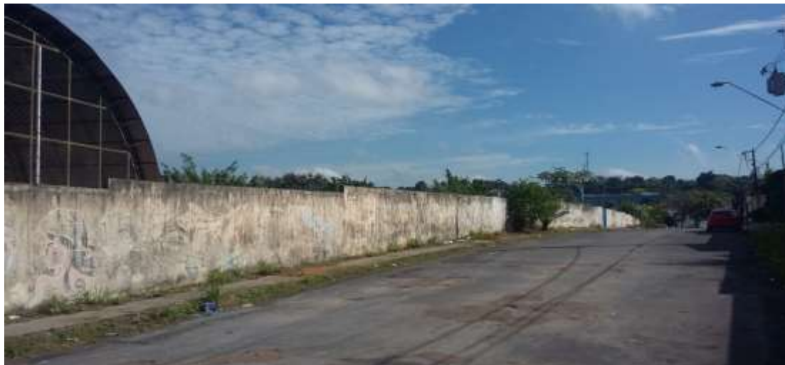
Figura 9. Muro baixo e sem proteção em uma escola pública estadual na zona norte da Cidade de Manaus.
