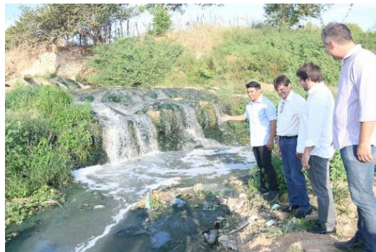
Figura 4 – Falta de tratamento de esgoto na cidade de Imperatriz (MA)
