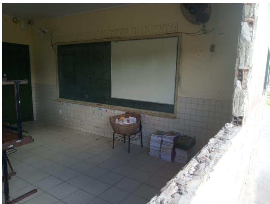
Figura 14: Janela demolida
