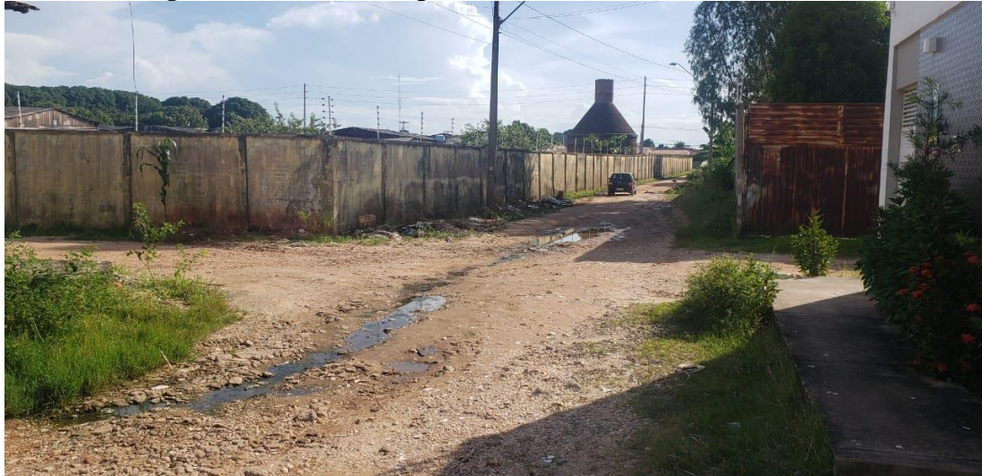
Figura 8 - Estrutura de esgoto a céu aberto no Bairro de Santa Inês
