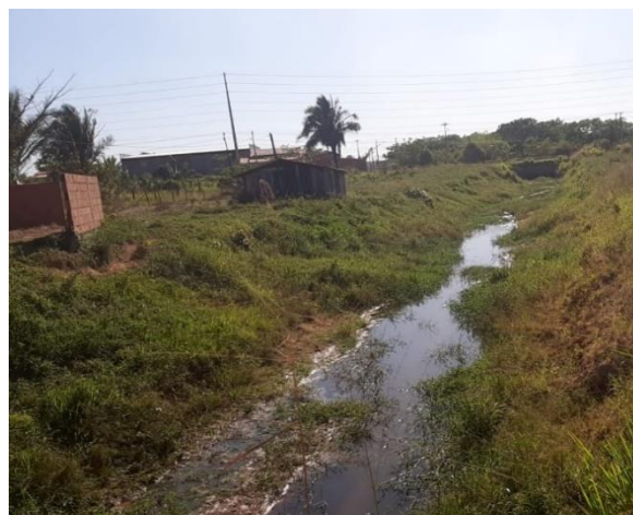
Figura 6. Ponto 3: leito do Riacho Bacuri com presença de erosão e modificação do leito
