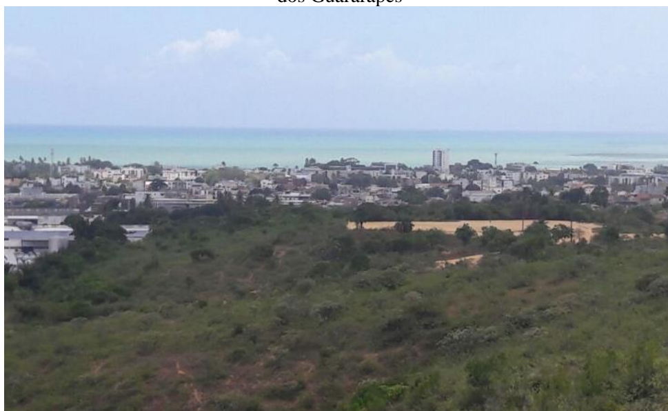
Figura 15: vista da área urbana e a proximidade do litoral no município de Jaboatão dos Guararapes
