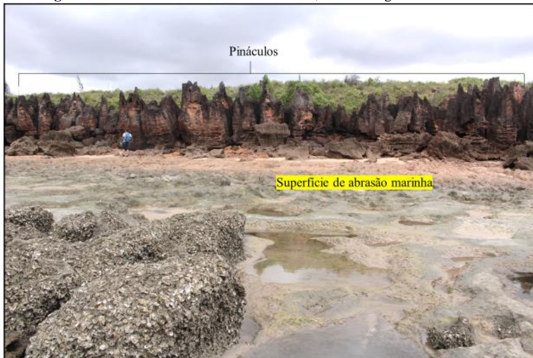
Figura 4 - Pináculos da falésia Ponta do Reduto, em São Miguel do Gostoso-RN
