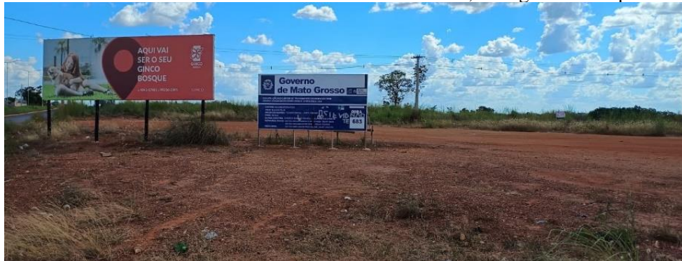
Figura 7. Outdoor com anúncio do empreendimento Ginco Bosque e outdoor da retomada das obras do Centro Oficial de Treinamento de Várzea Grande, na região do Chapéu do Sol
