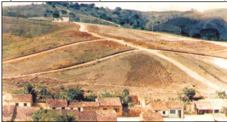
Figura 4. Vista parcial da construção do conjunto habitacional Cidade de Deus - Viçosa – Alagoas.
