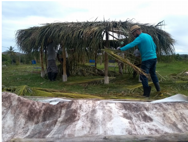
Figura 3. Bioconstrução de um galinheiro na área do Espaço de Vivência (ECOPAR).
