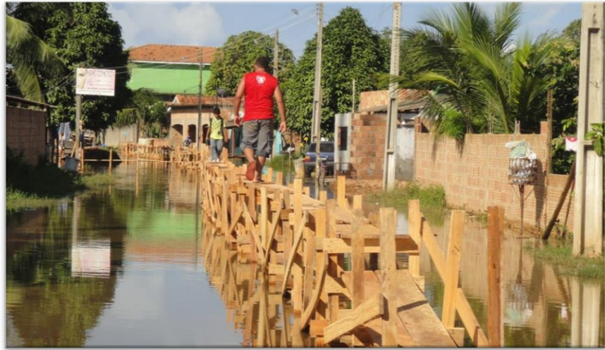
Figura 4- Ponte de madeira construída sobre a rua alagada na cheia de 2012.
