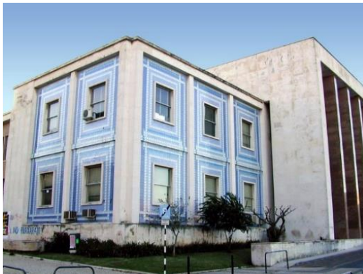
Figura 25 – Fachada do Edifício da Reitoria da Universidade de Lisboa.
