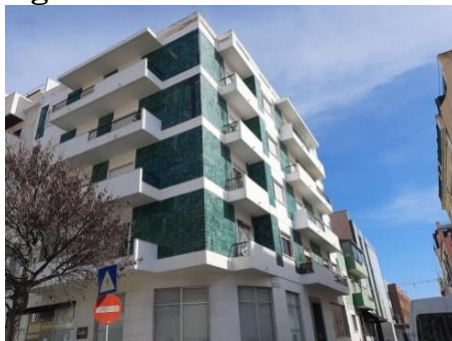
Figura 21 – Edifício em Lisboa.
