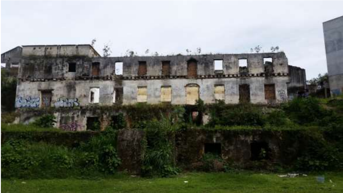
Ilustración 2. La exfábrica de San Bruno, parte del edificio del siglo XIX. Fotografía. Roca.
