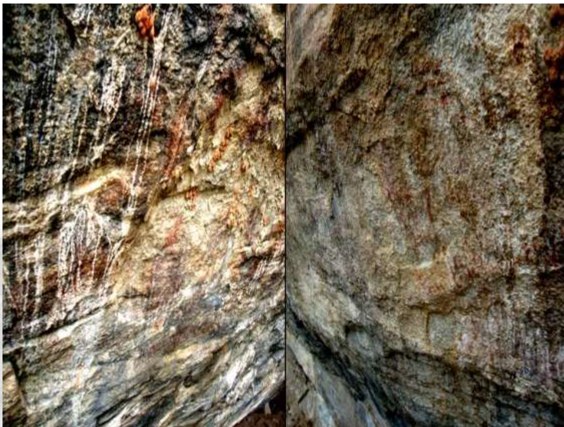
Figura 10 – Painéis de pintura rupestre encontrados no Sítio Telha, muitos em estado avançado de degradação por uma variante de fatores. (Fonte: arquivo pessoal dos autores, 2015)
