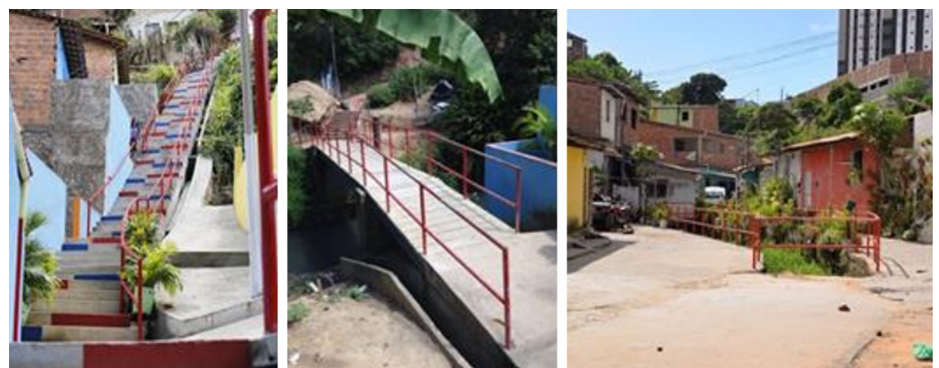
Figura 3 – Detalhe de urbanização na Grota do Aterro Fonte: SETRAND (2016); Polyanna Santos e SEINFRA (2018)
