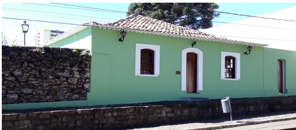
Foto: CANALLI, 27 de julho de 2019 (Arquivo particular).
