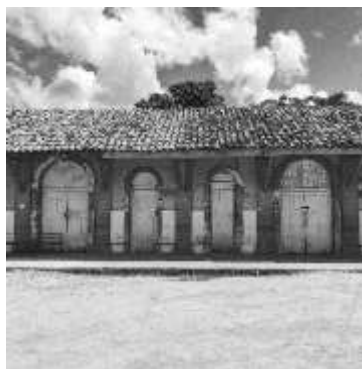
Figura 8 - Antiga Estação Ferroviária tombada pelo IPHAN
