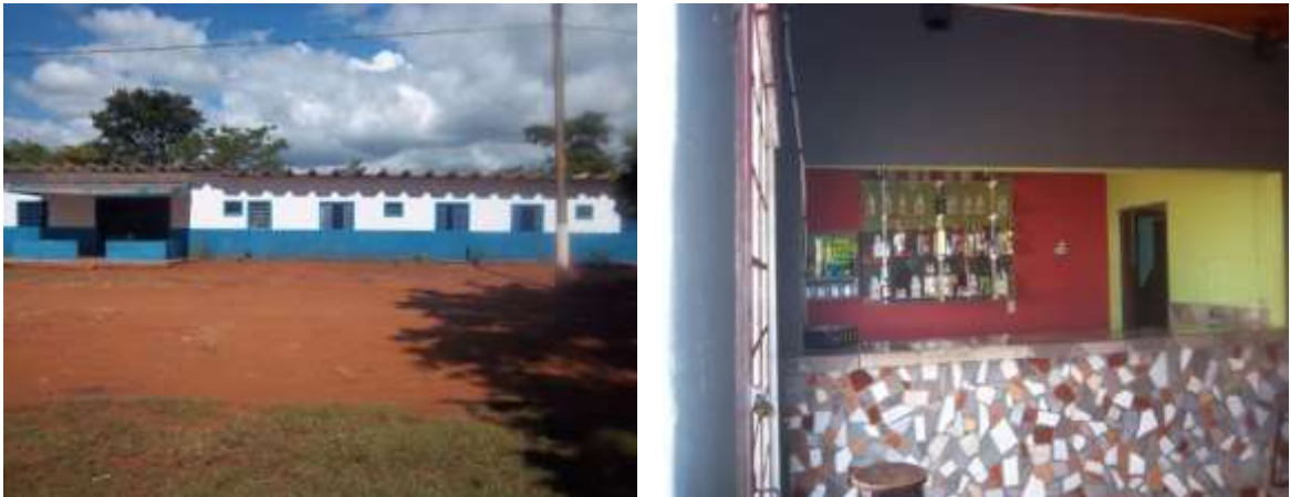
Figura 2 - Fachada e Bar do Corujinha
