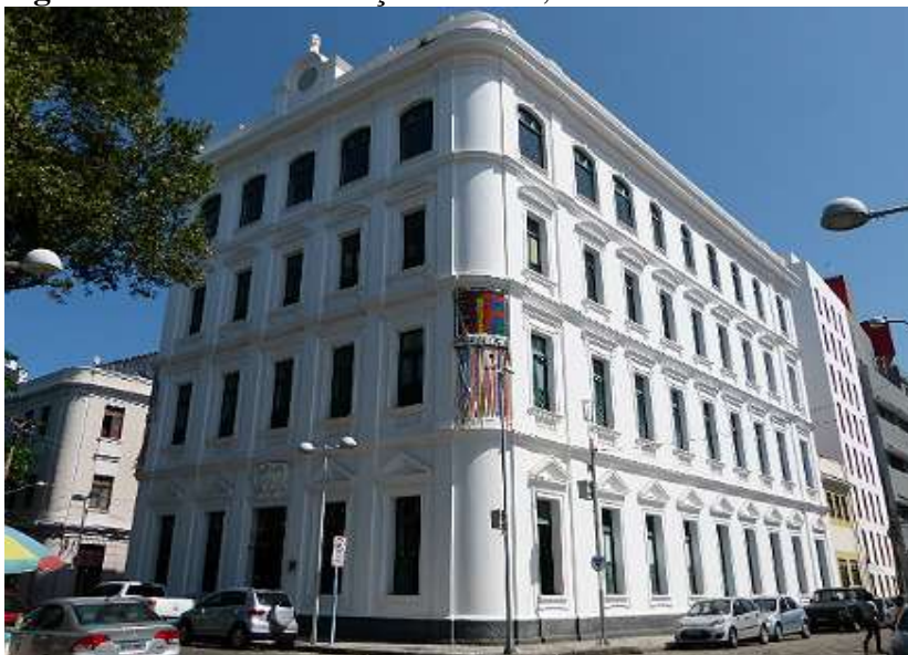
Figura 2 – Fachada do Paço do Frevo, fevereiro de 2018
