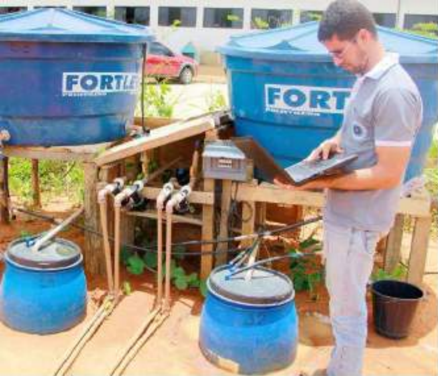
Rony faz o monitoramento diário da quantidade de água usada nos canteiros
